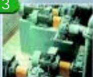
Digital-Tacho POG 9 mit EURO-Flansch® B10, ursprünglich entwickelt für Papiermaschinen (deshalb P), hat eine weite Verbreitung gefunden: hier an den Antrieben einer Klimazentrale.
