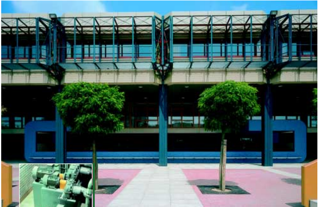
Einsparung von Energie: Wartungsarm und mit hohem Wirkungsgrad erzeugt ein System von 150 Wärmepumpen das optimale »Lernklima« einer Schule. In die Drehzahl-Regelung der Asynchronmotoren sind Digital-Tachos POG 9 von HÜBNER eingebunden.
