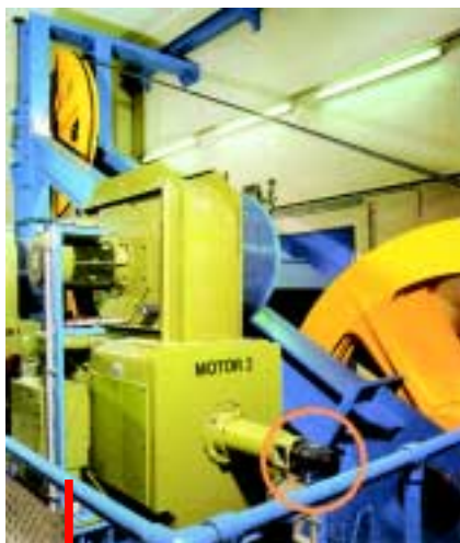
Bild 14: Tachos mit eigener Lagerung bilden eine robuste Einheit mit der Antriebsmaschine (hier TDP 0,2 an einem der 500 kW-Antriebe der Zugspitz-Seilbahn).
